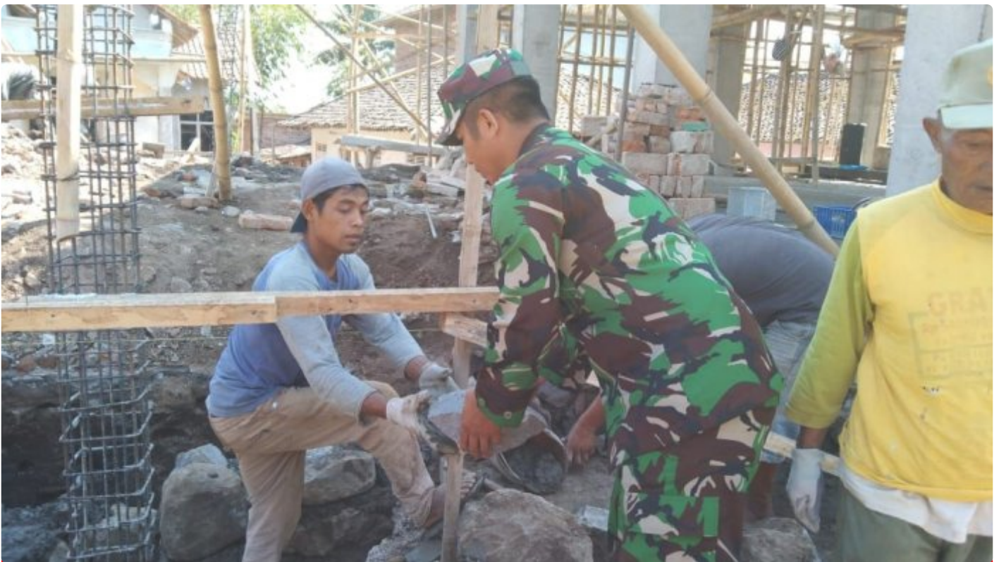
Serda Nasikin bantu pemasangan batu pondasi masjid
